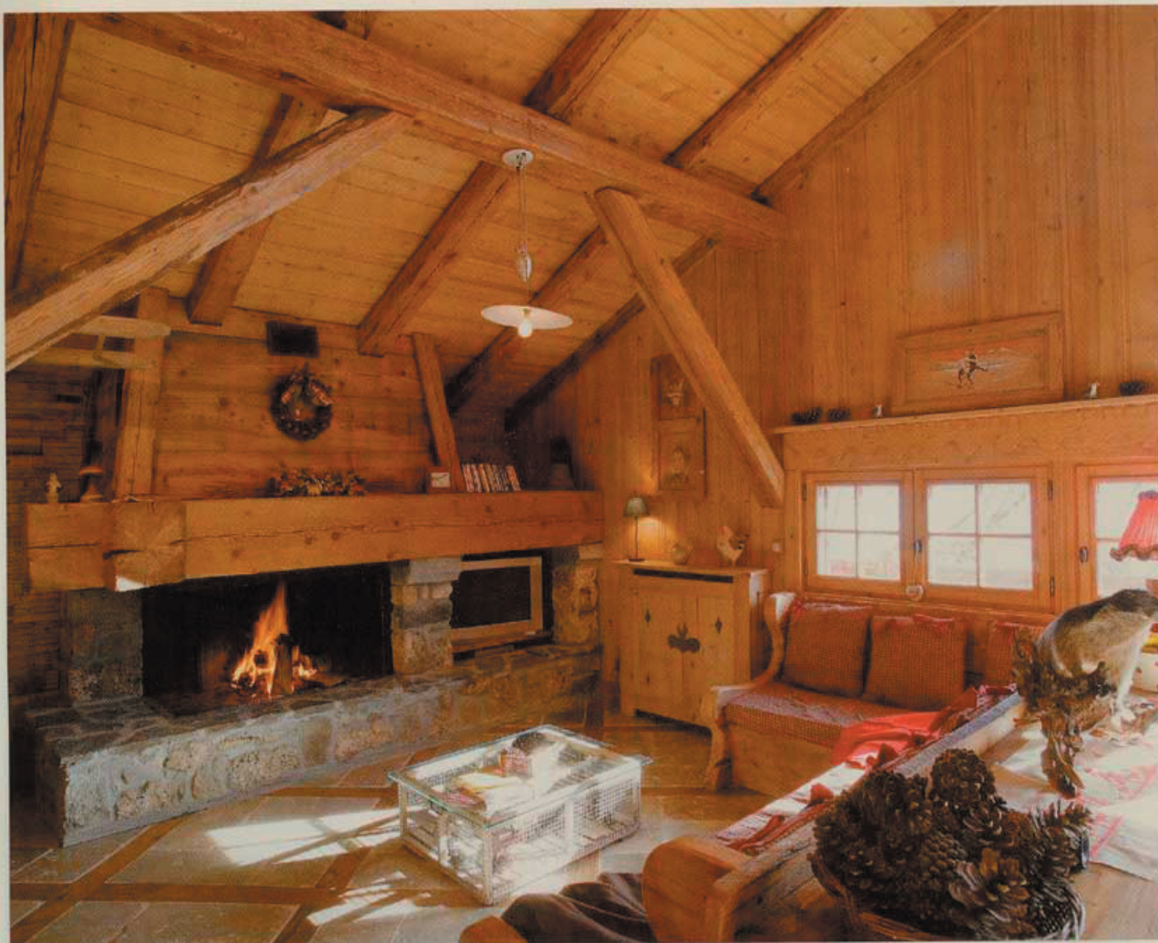
Du tuf, du granit et de la lauze composent la partie minérale de cette belle cheminée sur laquelle reposent des poutres aux dimensions généreuses. Elles viennent renforcer la composition massive de l'ensemble. La cassette escamotable a été faite sur-mesure pour permettre de faire brûler des bûches de 1 mètre.
